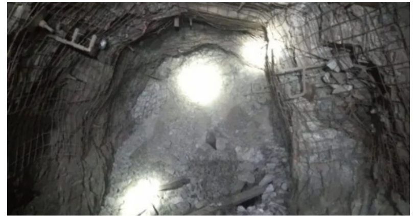
Imagen del acceso. A la mina en la que un derrumbe dejó atrapados a 17 mineros
